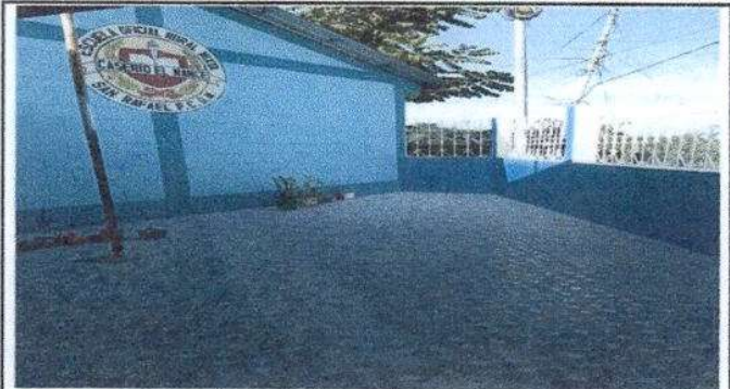
Foto 2: El piso del patio terminado con su pintura de muros
