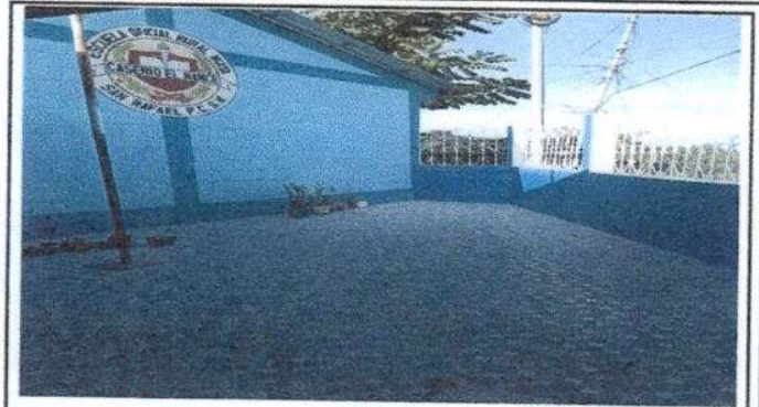
Foto 2: El piso del patio terminado con su pintura de muros
