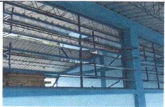
Foto 4: La estructura de metal de ventana
