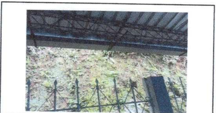
Foto 5: Los canales fueron sustituidos por canales de metal
