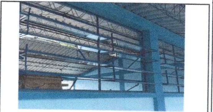
Foto 4: La estructura de metal de ventana
