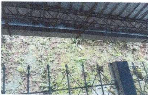
Foto 5: Los canales fueron sustituidos por canales de metal
